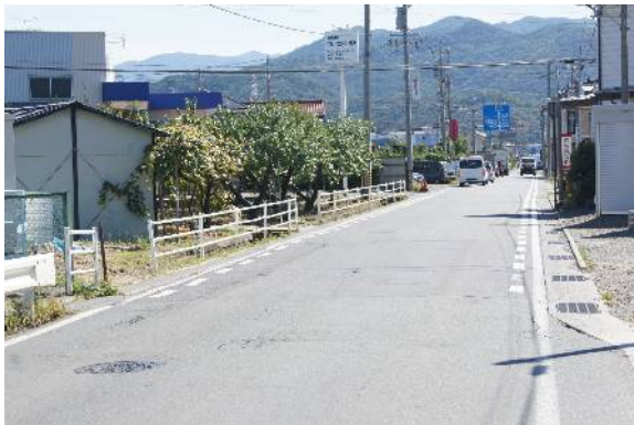
県道沿いの水路 川幅は1.5M
