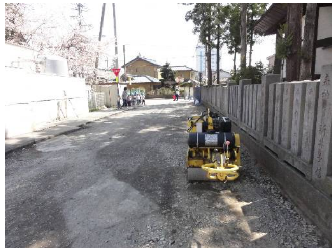
道路全面再舗装
